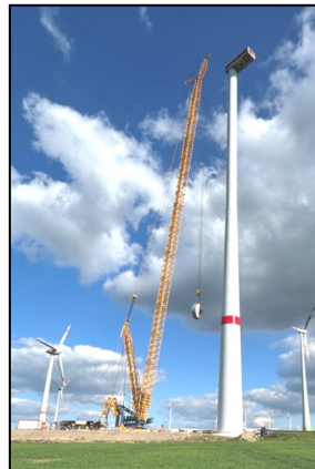
Vor der Flügel-Montage wurde das rechteckige Maschinenhaus montiert und hier auf dem Bild auch der Generator emporgezogen
