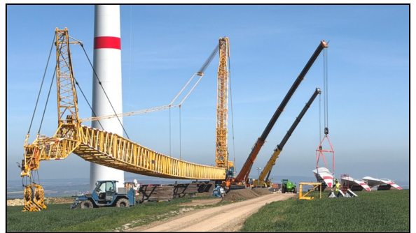
Vor dem Start der Rotorblattmontagen wurden die drei Flügel neben dem Anlagenturm und vor dem Großkran mit den beiden Hilfskränen zugbereit gelagert
