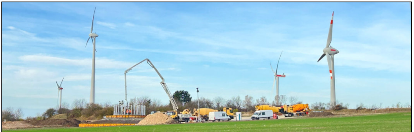
Bei den Umbauarbeiten auf dem Druiberg wurden inzwischen 10 Windräder einschließlich der kompletten Fundamente zurückgebaut und aller Beton für den weiteren Wegebau klein geschreddert. Nach Beräumung der alten Fundament- und Kranstellflächen wird mit einer abschließenden Mutterbodenschicht der ursprüngliche Zustand bestmöglich wiederhergestellt. Parallel sind die 13 Neu-Fundamente im Bau. Am 26. März 2026 findet im Adlersaal die nächste Bürgerinformation statt mit Schwerpunkt auf „Finanzielle Teilhabe“
